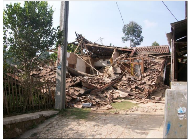
Gambar 1. Kerusakan Rumah akibat Gempa Bumi Jawa Barat, 2009
